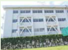
災害時の安全確保のための耐震工事は昨年8月に完了
